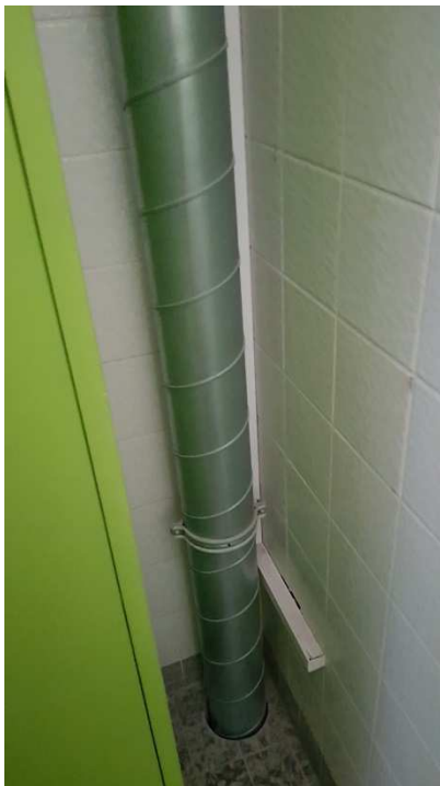
Foto Nr. 36 Lüftungsleitung durch Fußboden zur Lehrwerkstatt. Brandschutzmaßnahmen fehlen.
