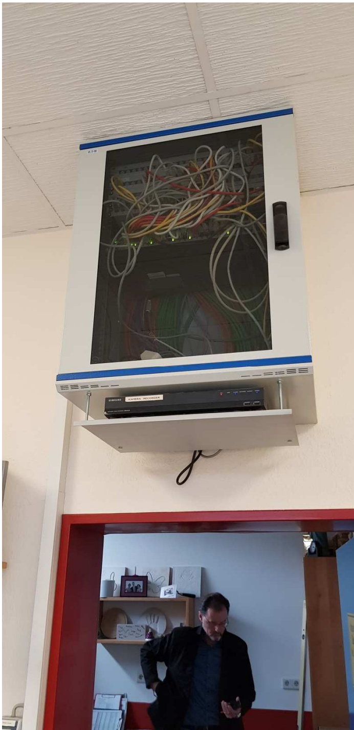
Foto Nr. 17 Datenschrank über einer Tür in einen Nachbarraum in der Verwaltung.
