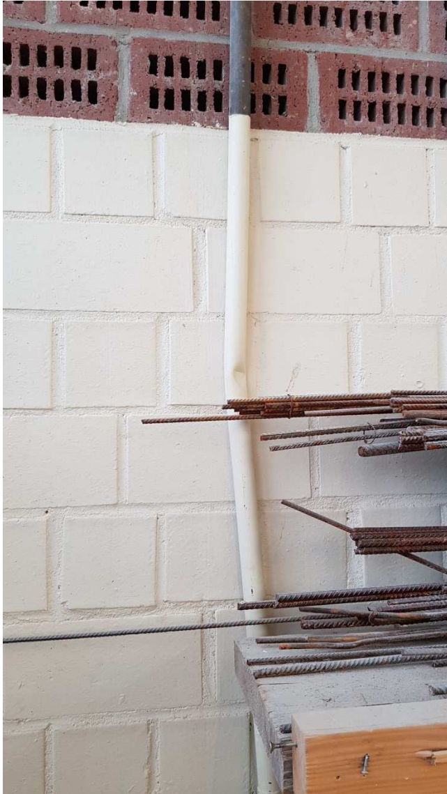
Foto Nr. 22 Beschädigte Trinkwasserleitung
