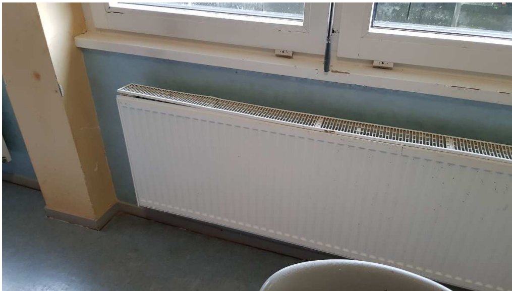
Foto Nr. 33 Blechheizkörper beschädigt.
