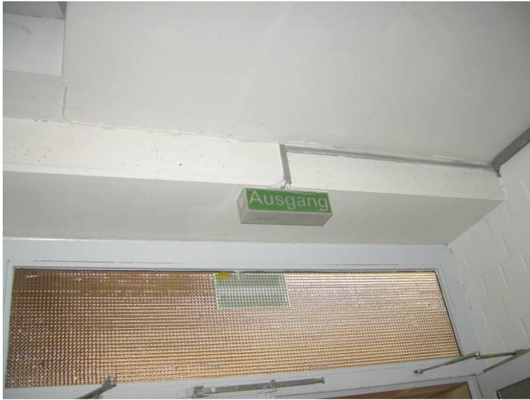
Foto Nr. 11 Rettungszeichenleuchte über einer Ausgangstür (ohne Funktion).
