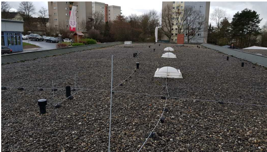
Foto Nr. 28 Bei manchen Abwasser-Entlüftungsleitungen fehlen die Deckel.
