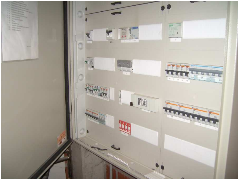
Foto Nr. 02 Erneuerte Unterverteilung im Bereich SHK-Technik. Es existiert jedoch nur ein Fehlerstromschutzschalter.
