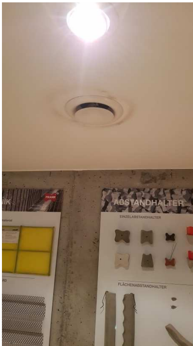
Foto Nr. 35 Schmutzring bei dem Tellerventil zeigt eine verschmutzte Lüftungsanlage.
