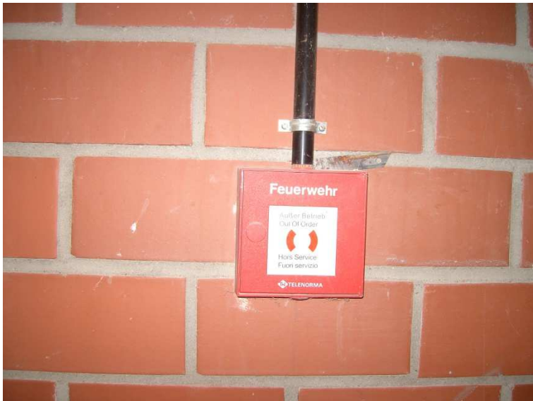
Foto Nr. 12 Handdruckmelder der Brandmeldeanlage (außer Betrieb).
